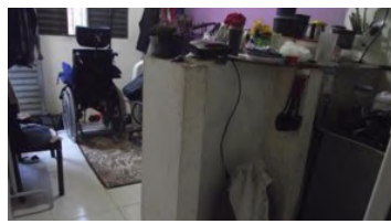
Inserção de uma bancada no local da parede demolida.
