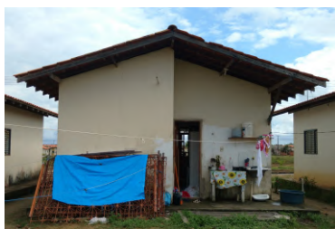
Vista dos fundos. Onde é prevista a ampliação da residência.
