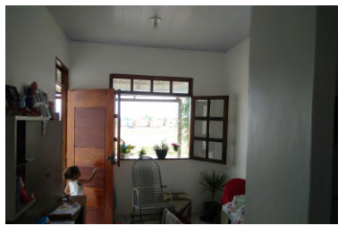
Troca de esquadrias da sala e forro de PVC já executados pela moradora.
