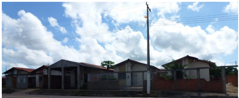
Figura 6 – Alterações nas edificações do CHMOS
