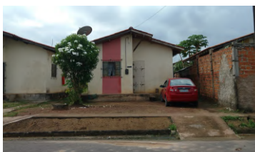
Frente da casa de Leila apenas com muro lateral realizado pelo vizinho.
