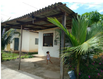
Cobertura e piso na área frontal e plantio já realizados pela moradora.
