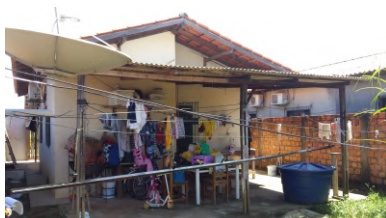
Fundos com cobertura já construída.
