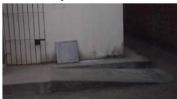
Construção de rampa para acesso.
