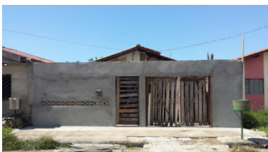
Frente da residência de Suellen, nota-se os muros já construídos e portões provisórios.
