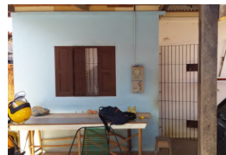
Substituição das janelas metálicas por de madeira, além de gradeamento para segurança.
