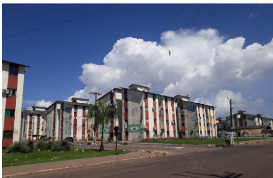
Conjunto Residencial Mucajá, 592 UHs, entregues em 2011 pelo Poder Público Municipal com recursos do PAC. Foto: Melissa Matsunaga, 2019
