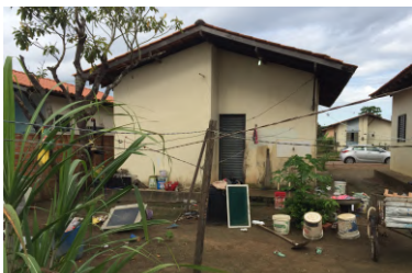
Quintal da residência, sem muros de divisa, com resíduos e objetos jogados.
