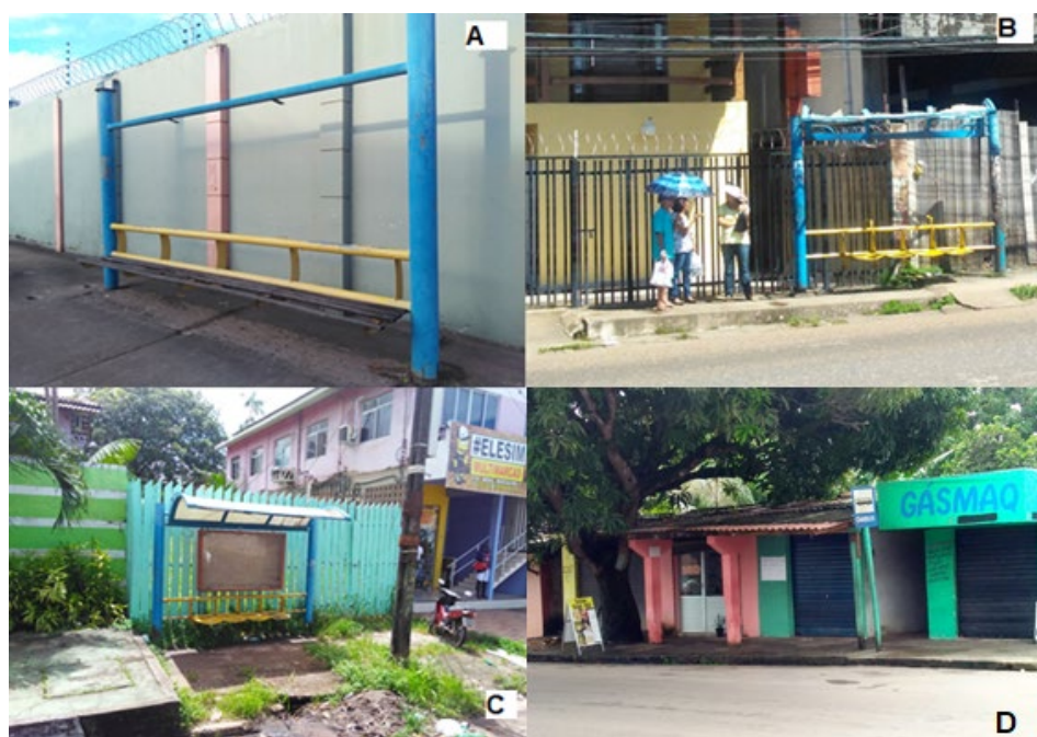
Figura 1 – Estrutura abrigos de parada de ônibus no município de Macapá (A) Rua Professor Tostes, (B) Av. Tiradentes, (C) Av. Antônio Coelho de Carvalho e (D) Rua Hildemar Maia
