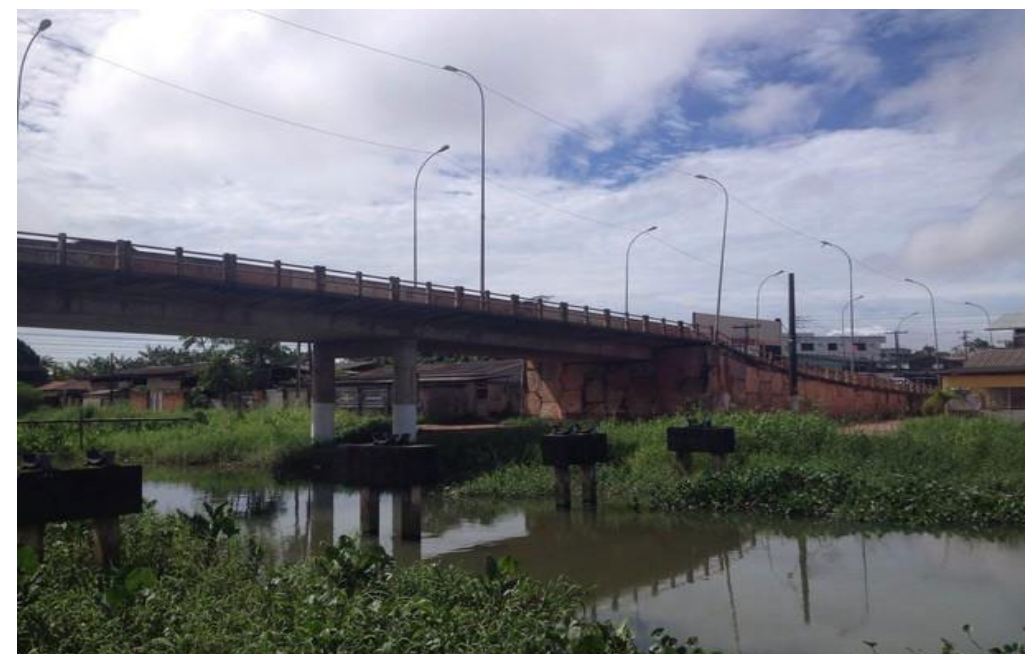
Figura 2 - Vista lateral da Ponte Sérgio Arruda sob o Canal do Jandiá.
