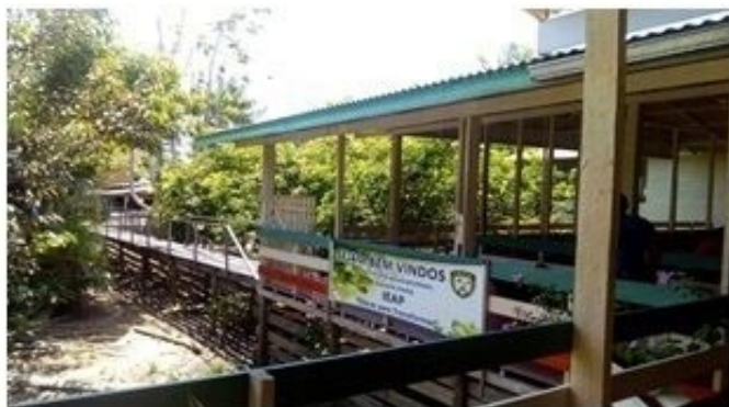
Figura 1- Entrada do Prédio do IEAP
