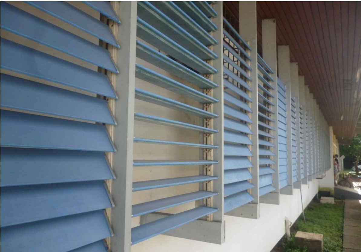
Figura 5. Projeto da veneziana móvel para Hospital Vila Amazonas, com ferragens em alumínio
