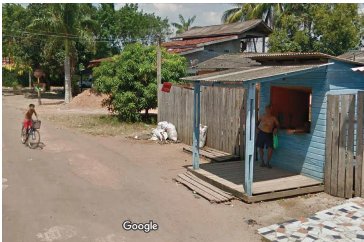
Figura 16. Casa 6: Venda de Açaf. Utilização de pilares duplos. Distância da Vila Amazonas, 700 mts, aproximadamente
