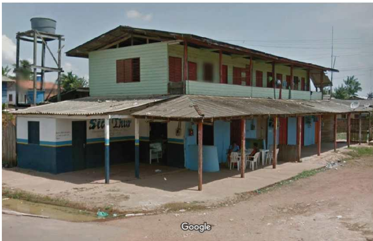
Figura 17. Casa 7: utilização de veneziana móvel frontal e lateral. Distância da Vila Amazonas, 200 mts, aproximadamente
