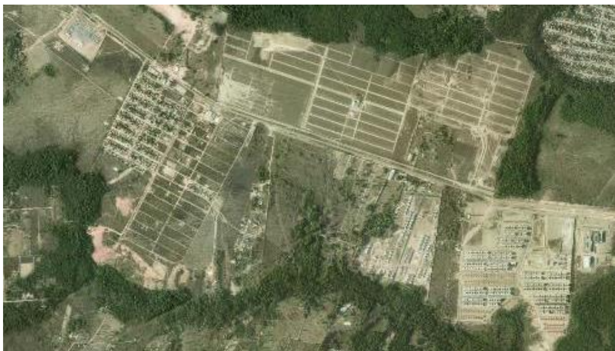
Figura 19. Vista de recorte do entorno do Conjunto Macapaba – autonomia da malha frente o substrato
