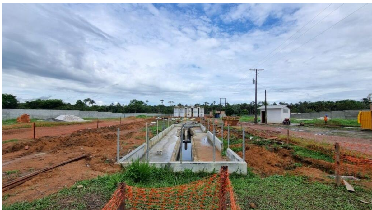
Figura 5: Ampliação da rede de esgoto em Macapá.
