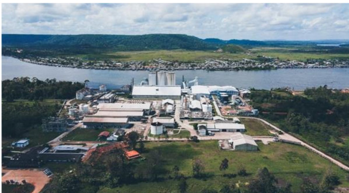
Figura 2: Fábrica CADAM, no lado Pará, município de Almeirim, em Vila Munguba.
